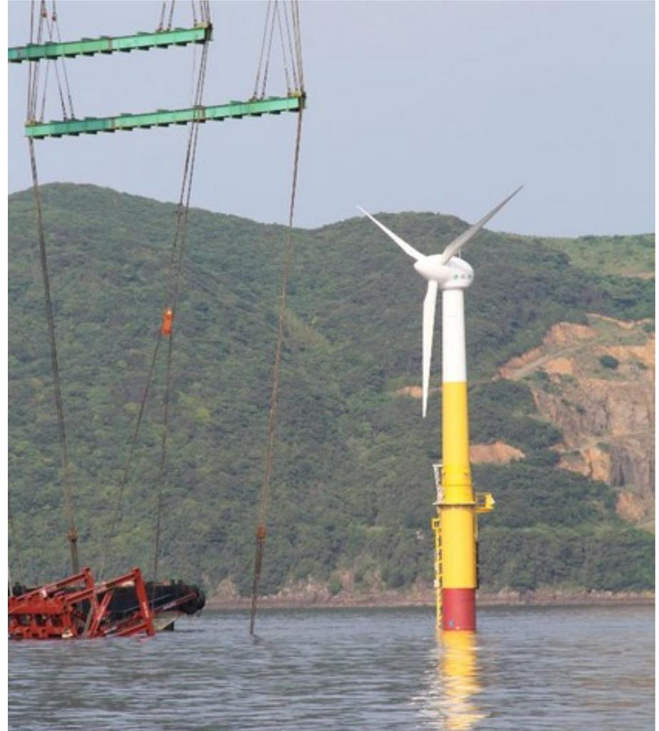
環境省浮体式洋上風力発電検証事業として2010年より稼働。現在は2000kW風車による検証実験中。
